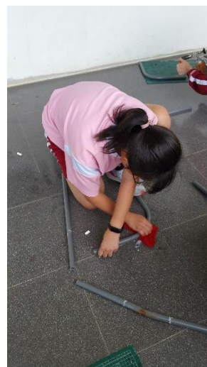
90°彎管—冷卻定形
