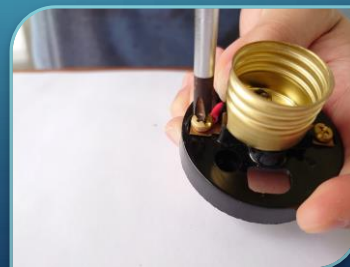
用起子將電線鎖緊
