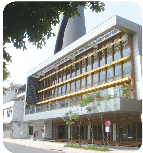
圖 4-24 淡水藝術工坊建築的開口皆搭配外遮陽，設置電動控制的遮陽帆布，能視日照狀況做調整，以節省日常使用能源
